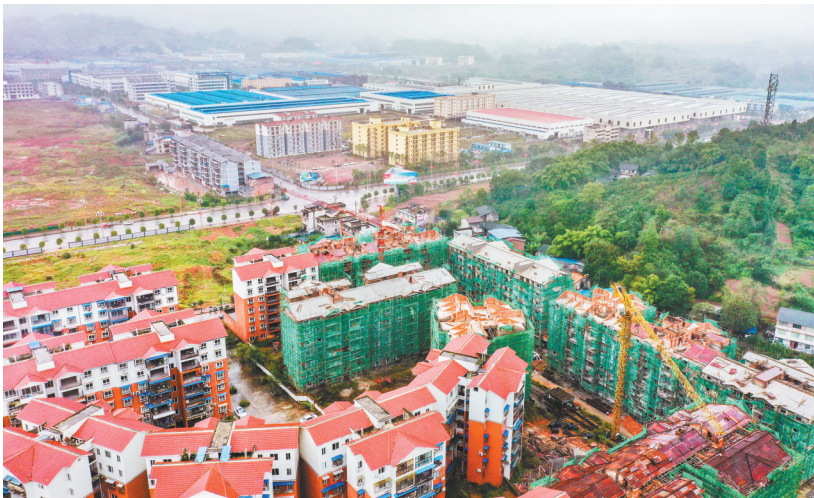
2021年10月20日,正在建设中的川渝高新新区平安寨社区。(资料图片) 首席记者 龙帆 摄/视觉重庆
