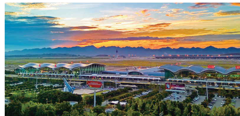
朝阳下的重庆江北国际机场 聂先福 摄/视觉重庆
