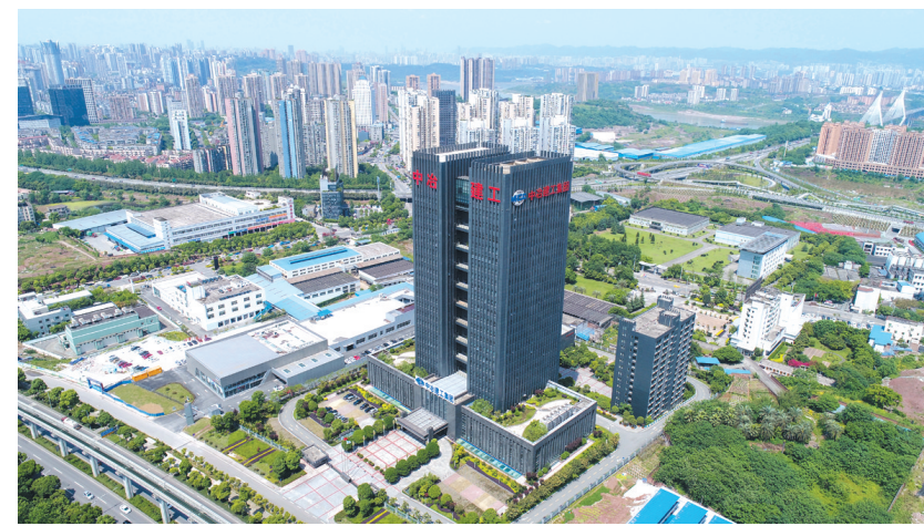
荣获中国建筑工程鲁班奖的中冶建工大厦
