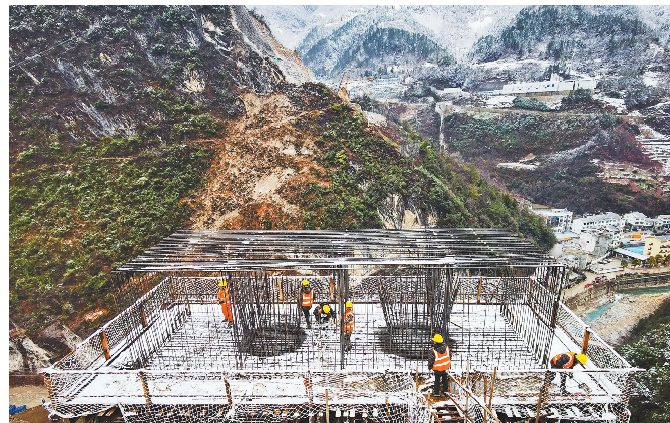
▲1月29日,城开高速重点控制性工程——琴子特大桥气温骤降,披上了薄薄的雪衣,建设者正在寒冬里紧张施工。春节期间,城开高速近千名参建人员坚守在一线岗位,战寒冬,狠抓安全生产,以保障年内高速公路通至城口县域的目标。
