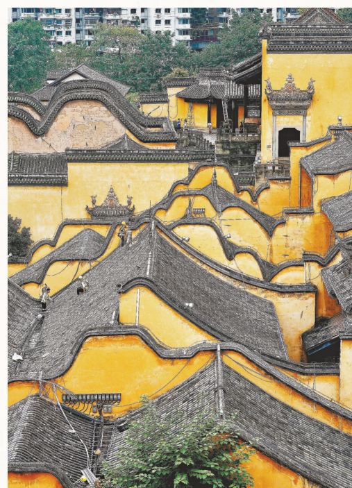
从东水门长江大桥人行道视角眺望湖广会馆，连绵不断的封火山墙依山势而下，蔚为壮观。
