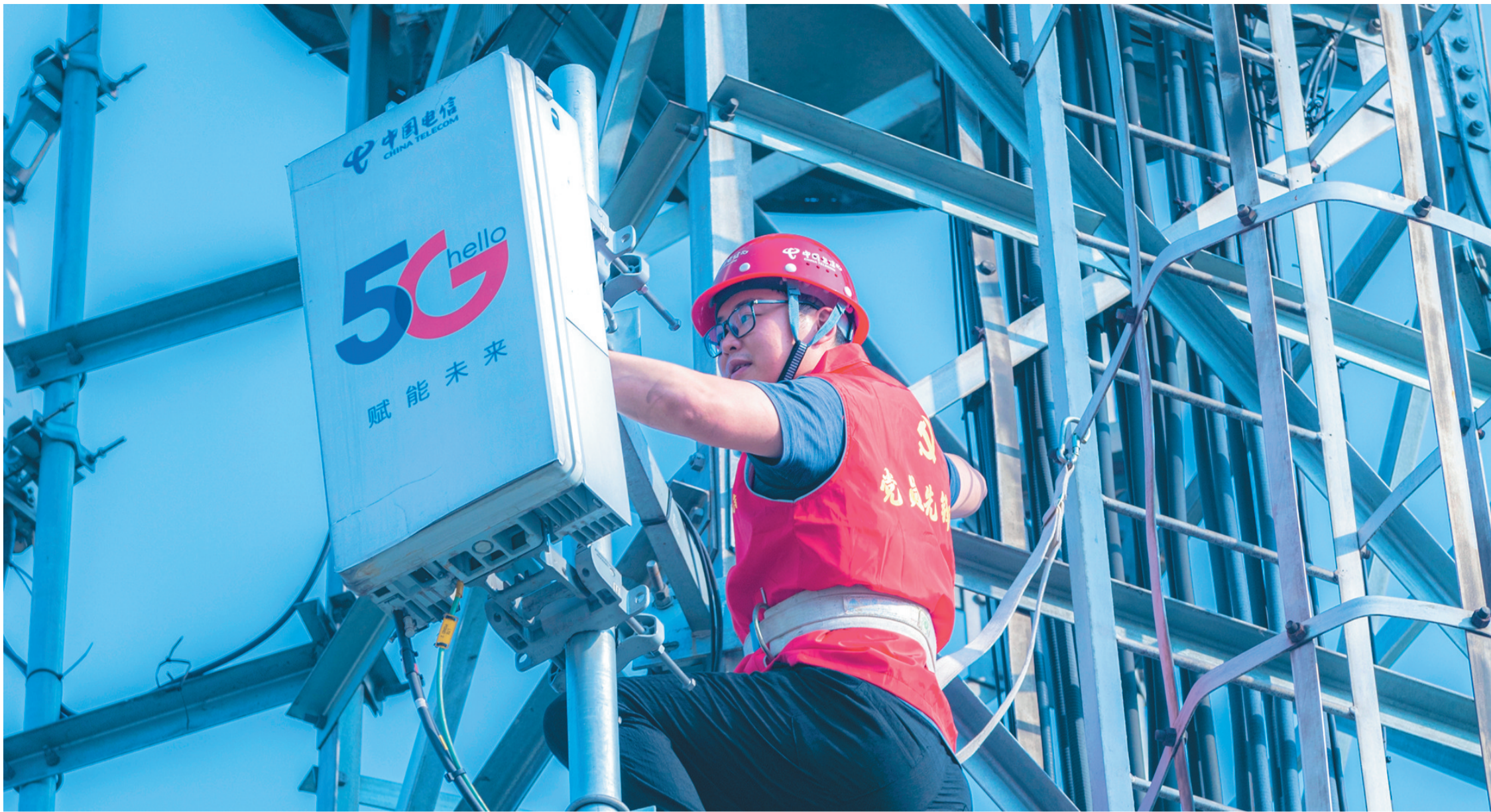
加大网络基础设施建设,赋能乡村振兴 摄/李远治
