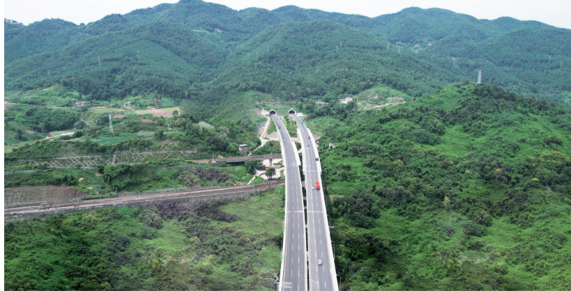
歌马隧道东西干道工程
