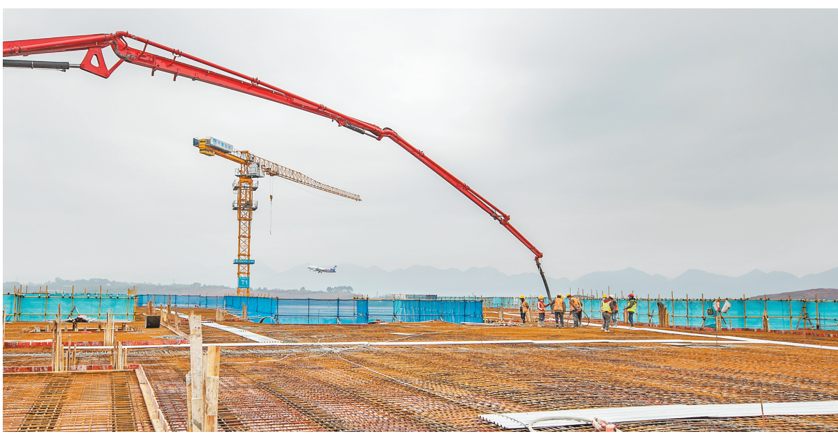
十二月二十七日,在重庆江北国际机场T3B航站楼项目施工现场,施工人员进行指廊主体结构封顶浇筑。新华社记者 黄伟 摄
