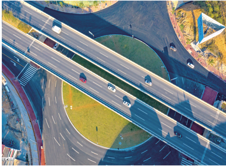
城市外环线连接川河盖景区旅游公路
