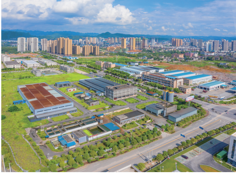
工业园区航拍图
