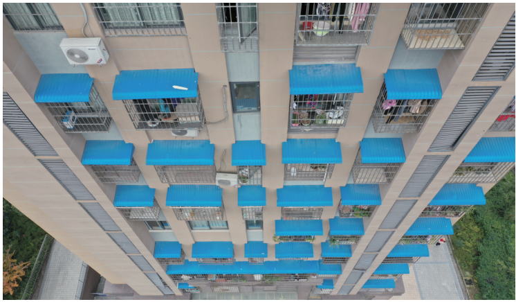
人和街道万年路社区俊和新青年小区更换后的阻燃雨棚
