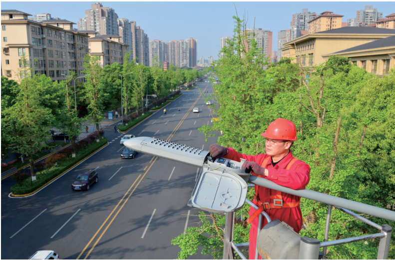
维修、管护城区照明设施，城区路灯亮灯率、完好率均达到99%以上
