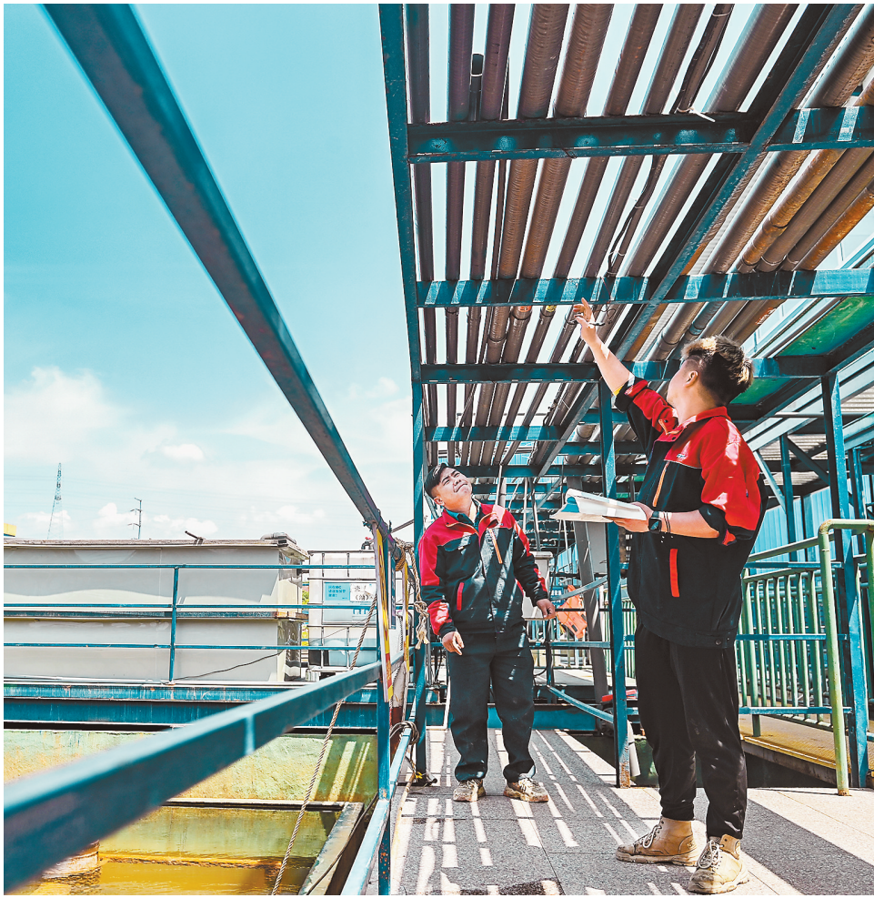
大足双桥经开区重庆智伦电镀园,工作人员正在检查污水管网是否有破损情况。(摄于4月27日) 首席记者 龙帆 摄/视觉重庆
