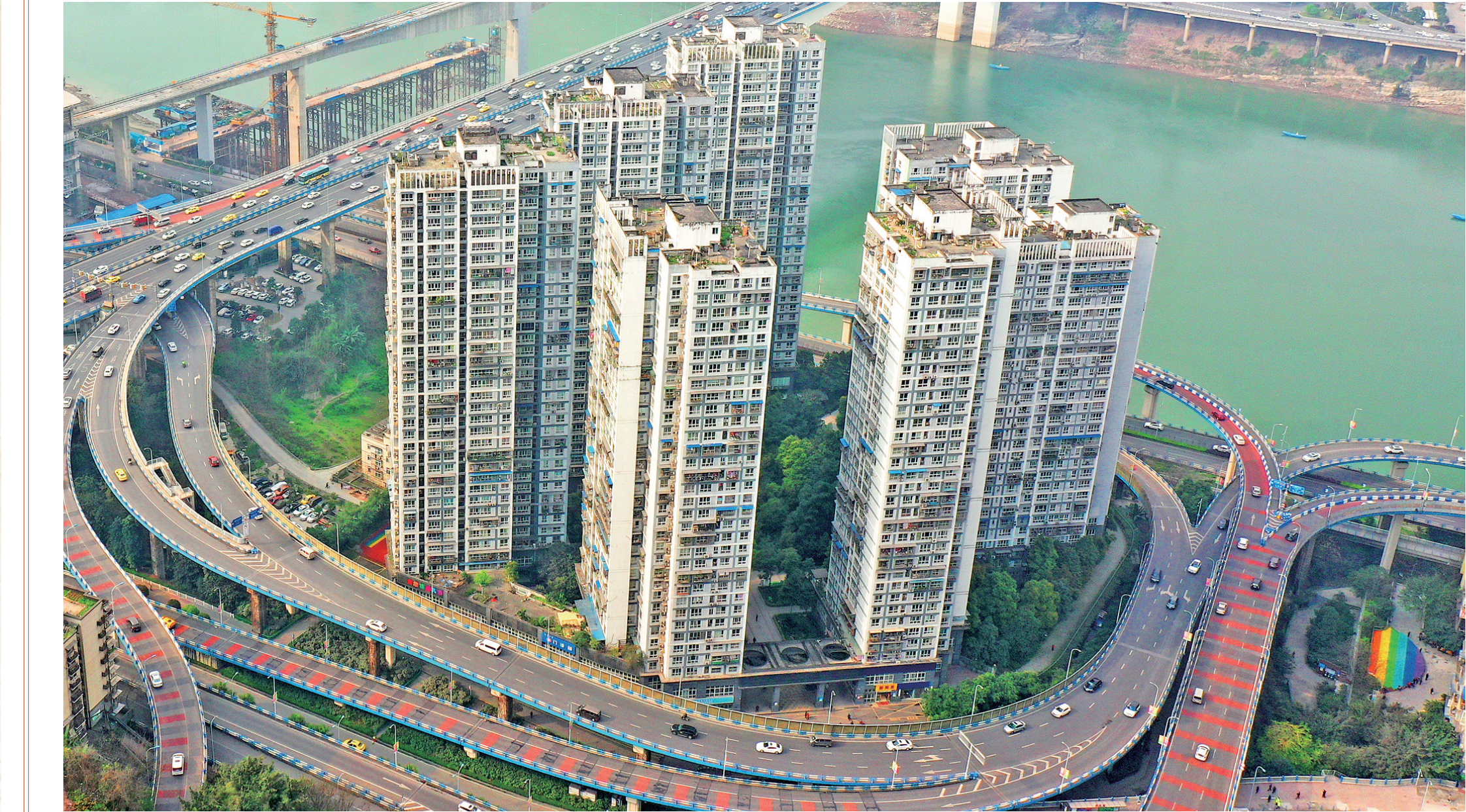
高层住宅雨棚全部换成了阻燃材料做成的雨棚,消防设施升级“焕新” 摄/钟志兵
