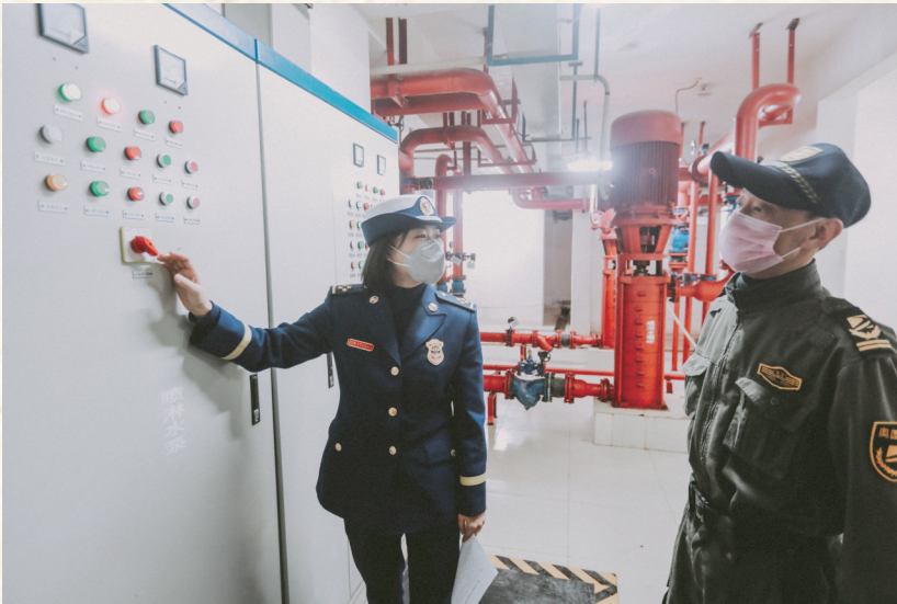
高层建筑消防检查
