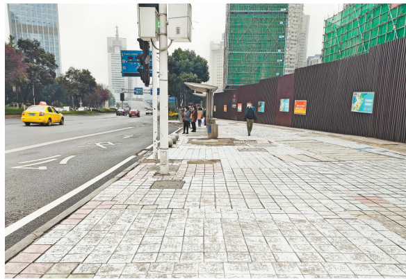
渝北区新溉路口惠普名车公交站天桥下的白色地砖已经进行了打磨防滑处理。
