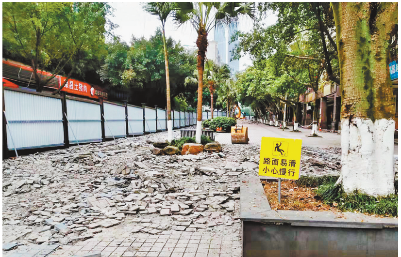
渝北区松石路支路人行道改造前后。 通讯员 袁镇涛 摄
