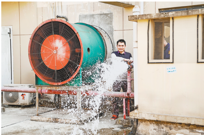
测试高层建筑消防水压
