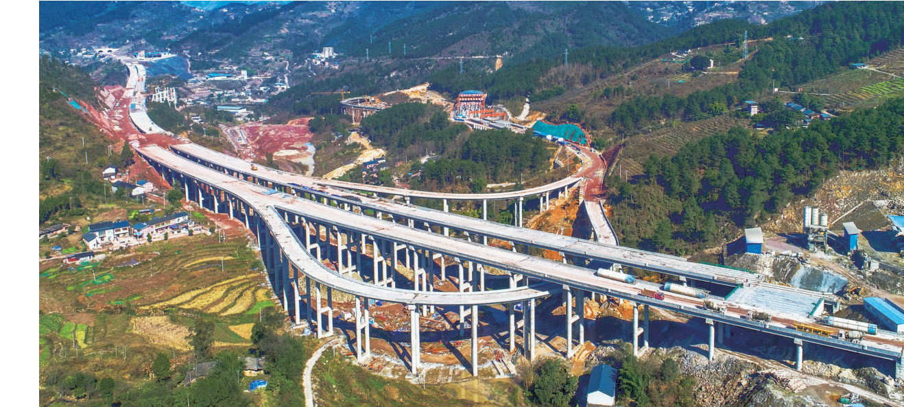
兴业银行重庆分行全力支持我市交通基础设施建设 摄 罗斌/视觉重庆
