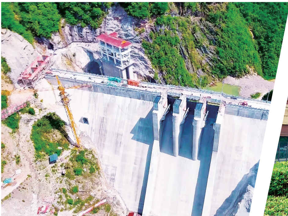
重庆兴农担保集团担保支持项目——城口龙峡水库电站
