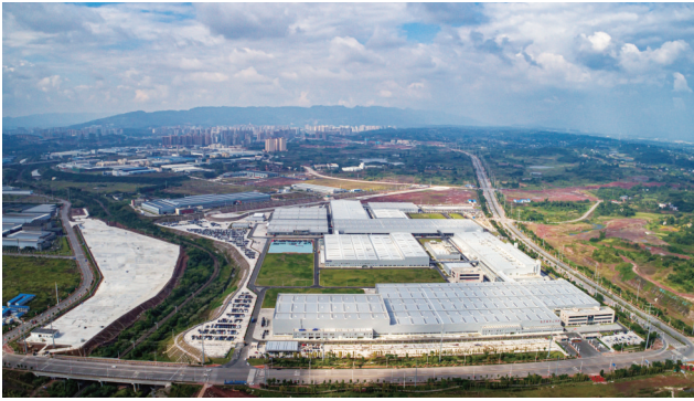
农发行重庆市分行信贷支持的永川区凤凰湖产业园公共配套设施提升工程
