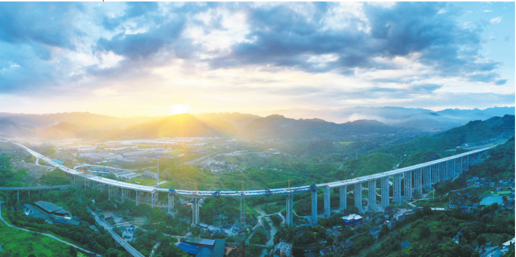
渝黔高速公路重庆万盛温塘特大桥正在合龙 曹永龙 摄/视觉重庆
