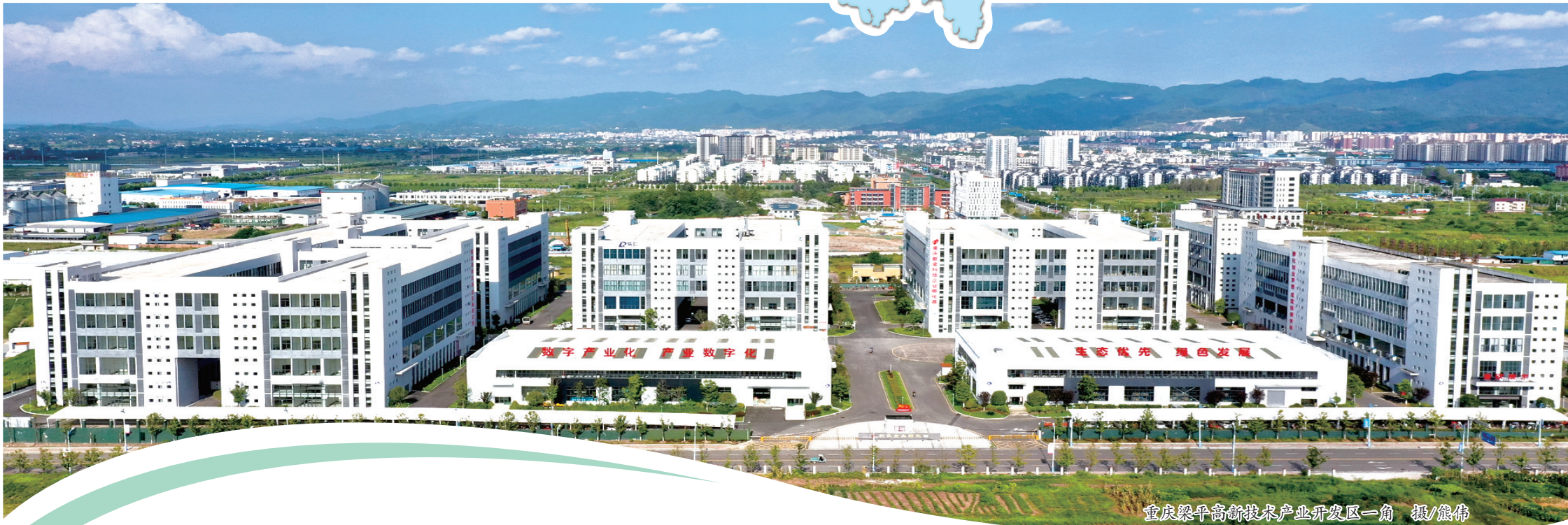
重庆梁平高新技术产业开发区一角 摄/熊伟
