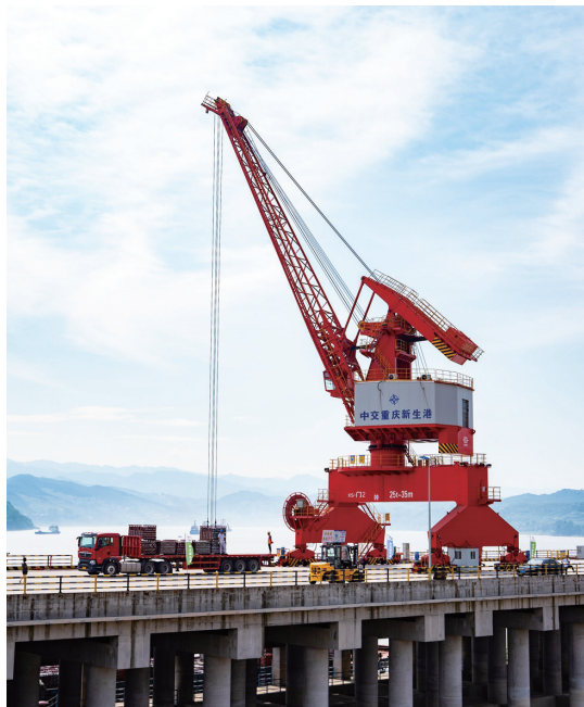
重庆新生港重载调试实拍
