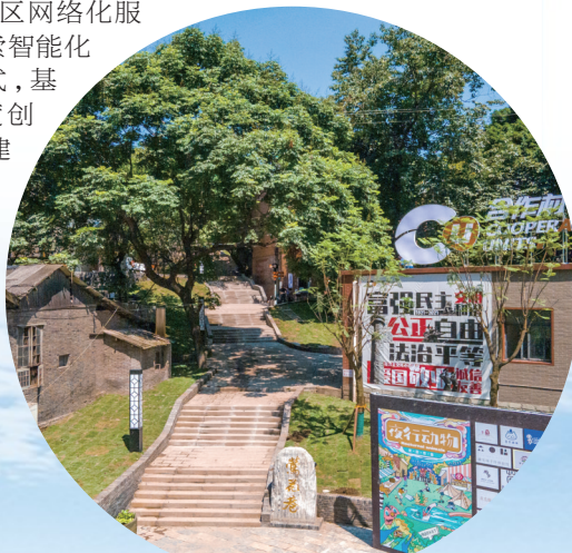
五里店合作村富强片区老旧小区更新改造工程示范项目 摄/李显彦
