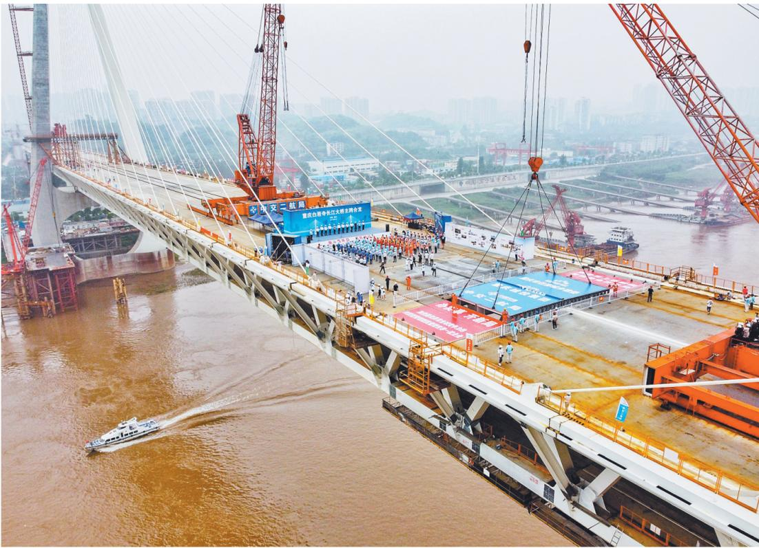
9月1日，世界最大跨度公轨两用钢桁梁斜拉桥——重庆白居寺长江大桥成功合龙，标志大桥距离年底通车目标又迈进了一步。
