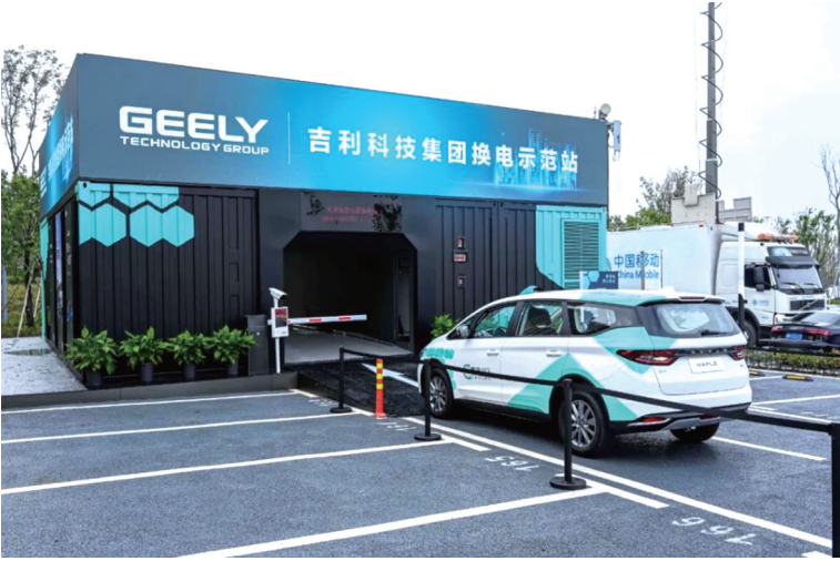
吉利科技换电示范站
