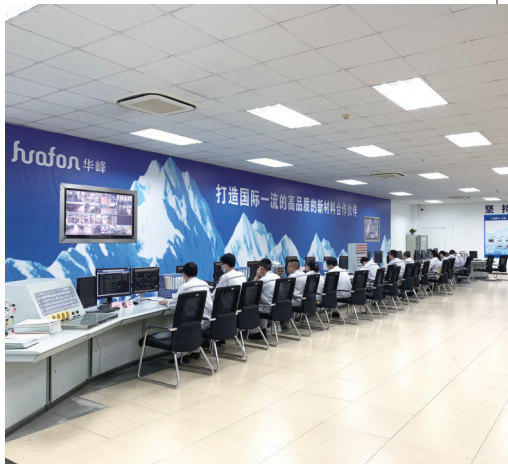
重庆华峰化工有限公司中心控制室
