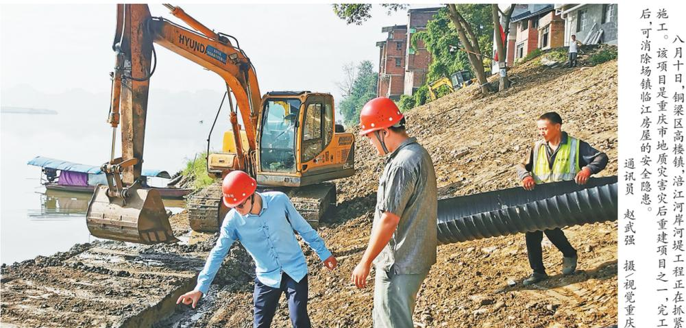
八月十日,铜梁区高楼镇,沿江河岸堤工程正在抓紧施工。该项目是重庆市地质灾害灾后重建项目之一,完工后可消除该镇临江房屋的安全隐患。通讯员 赵武强 摄/视觉重庆
