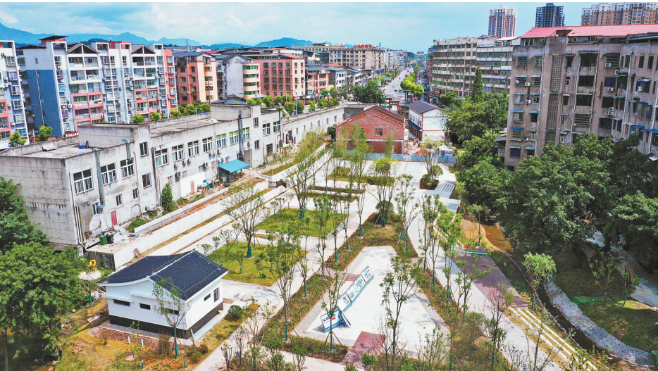
7月19日,无人机航拍的江津区李市小溪黑臭水体综合整治中建设的滨河生态景观公园。(江津区融媒体中心供图)
