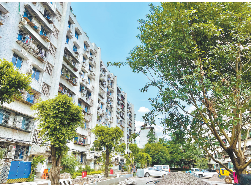
巴南区广益街项目实施老旧小区改造“手术”,面貌焕然一新。(图片由市住房城乡建委提供)
