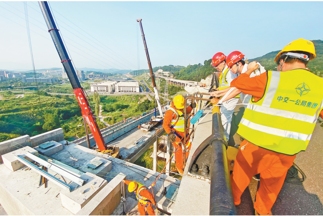
八月四日，中交一公局集团组织工人完成万州环线高速鹿山互通的 首节钢结构工字梁吊装。
