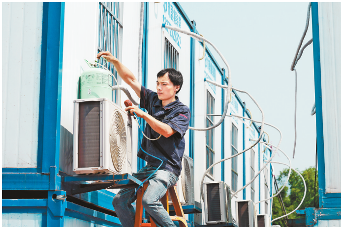
8月4日，西部（重庆）科学城北碚园区传感器特色产业基地，一名工作人员在检查维修空调。
