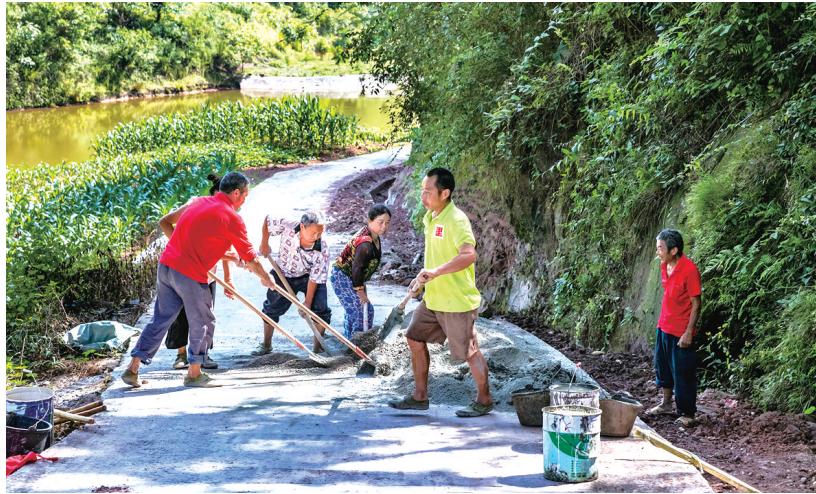
维新镇沿河村改造农村泥结石路 摄/舒富强
