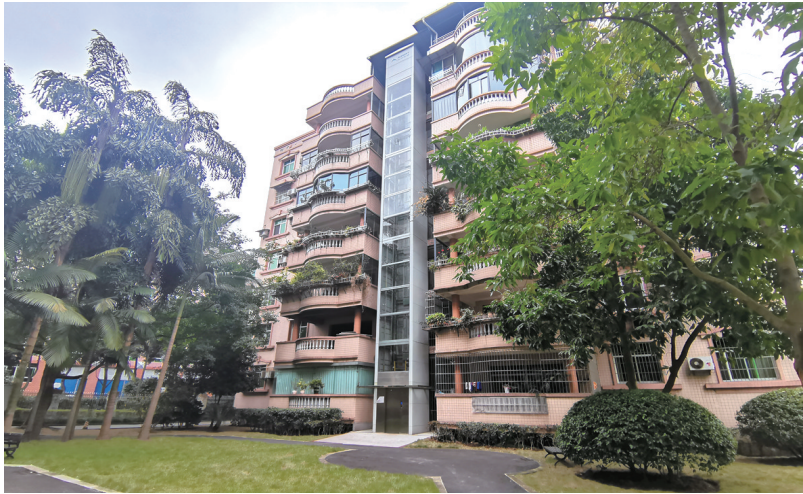
老旧小区加装电梯
