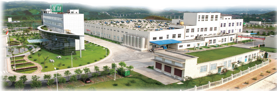
重庆农商行支持的重庆天友乳业股份有限公司渝北生产基地一角
