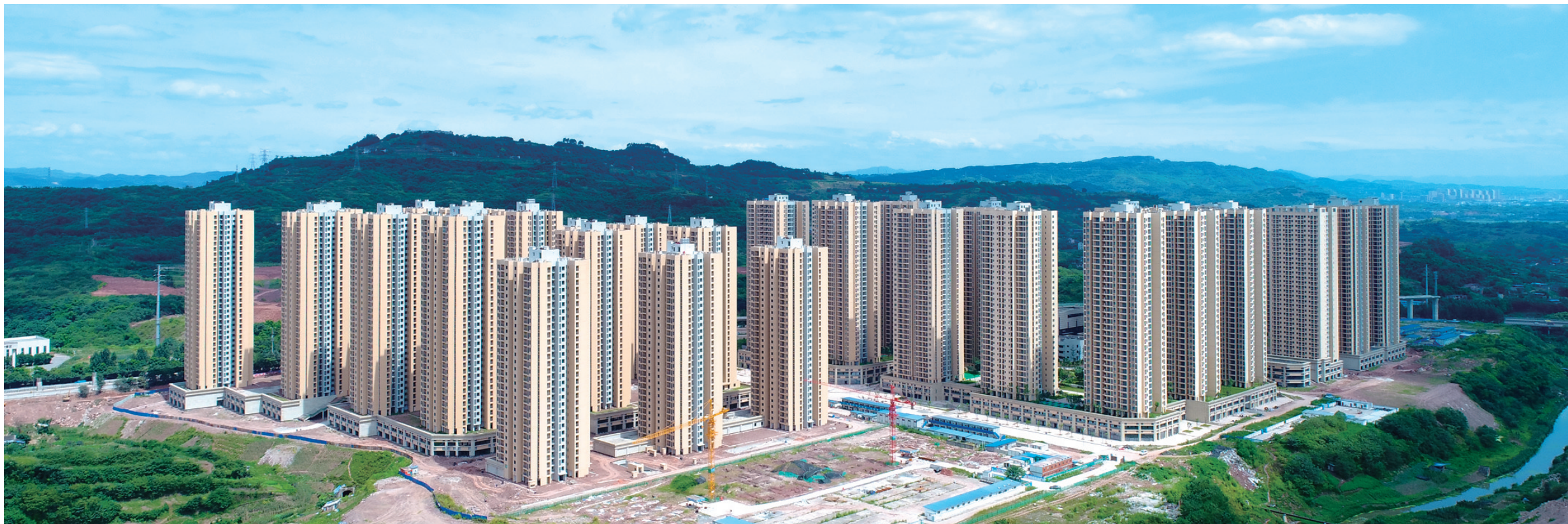
中冶建工承建的大渡口跳蹬幸福华庭公租房ADE组团项目
