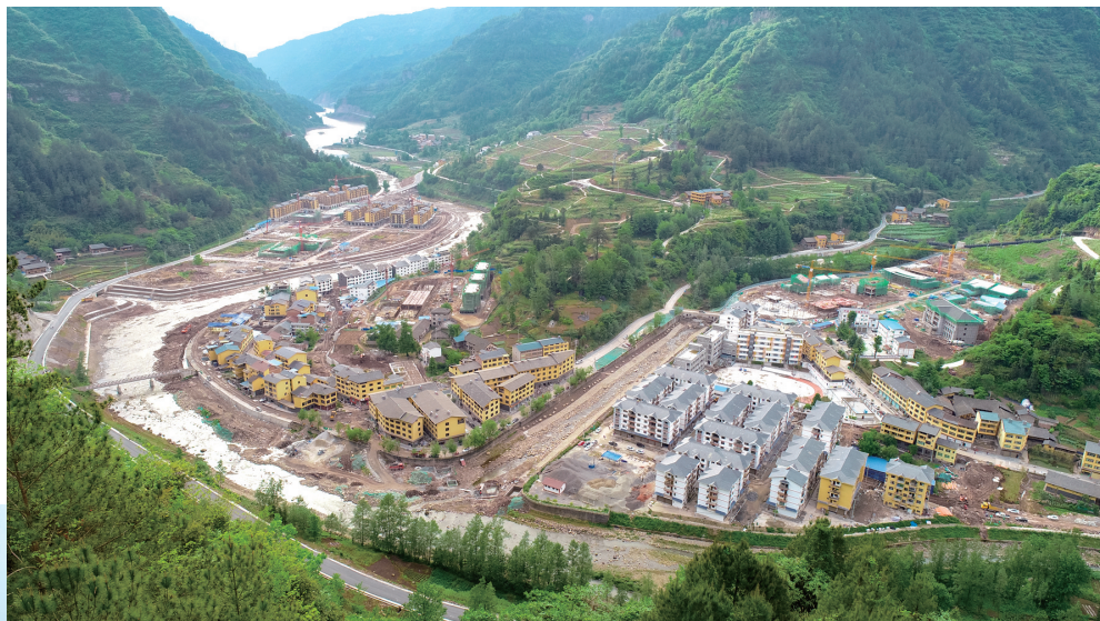
重庆石柱中益乡风貌改造扶贫项目
