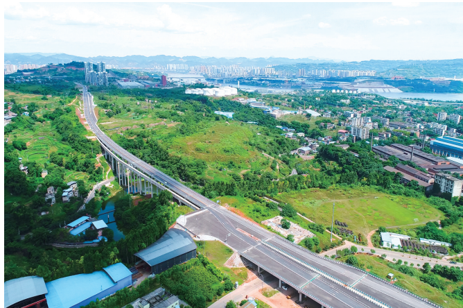
大渡口中坝路一期工程
