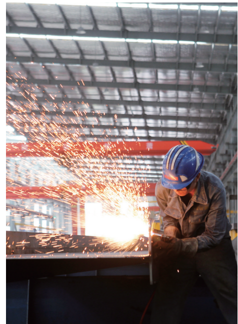
云阳县诚信杭萧钢结构项目施工现场 摄/朱学徽
