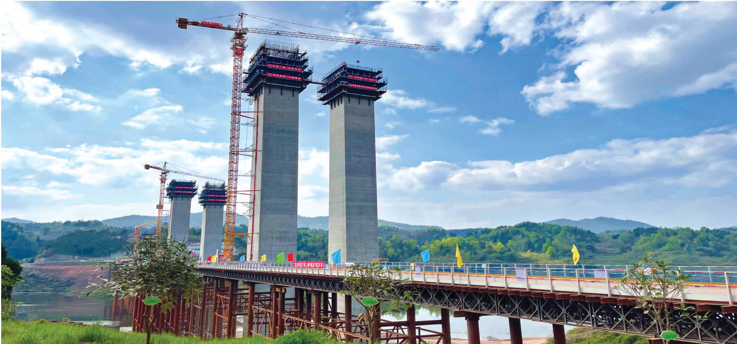
施工中的五布河特大桥
