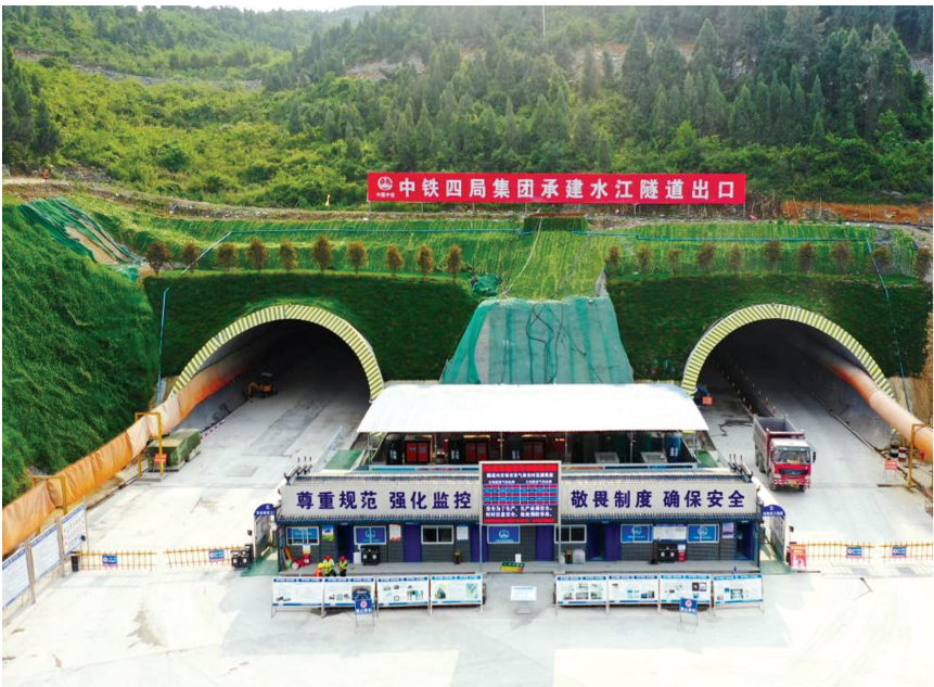
水江隧道进出口
