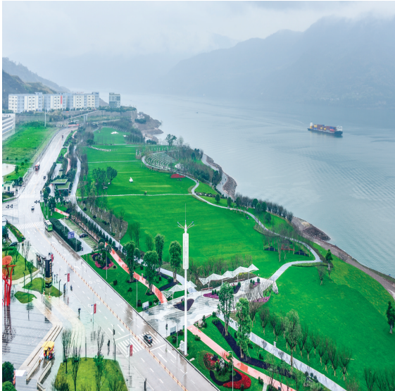
云阳县库岸环境综合整治项目
