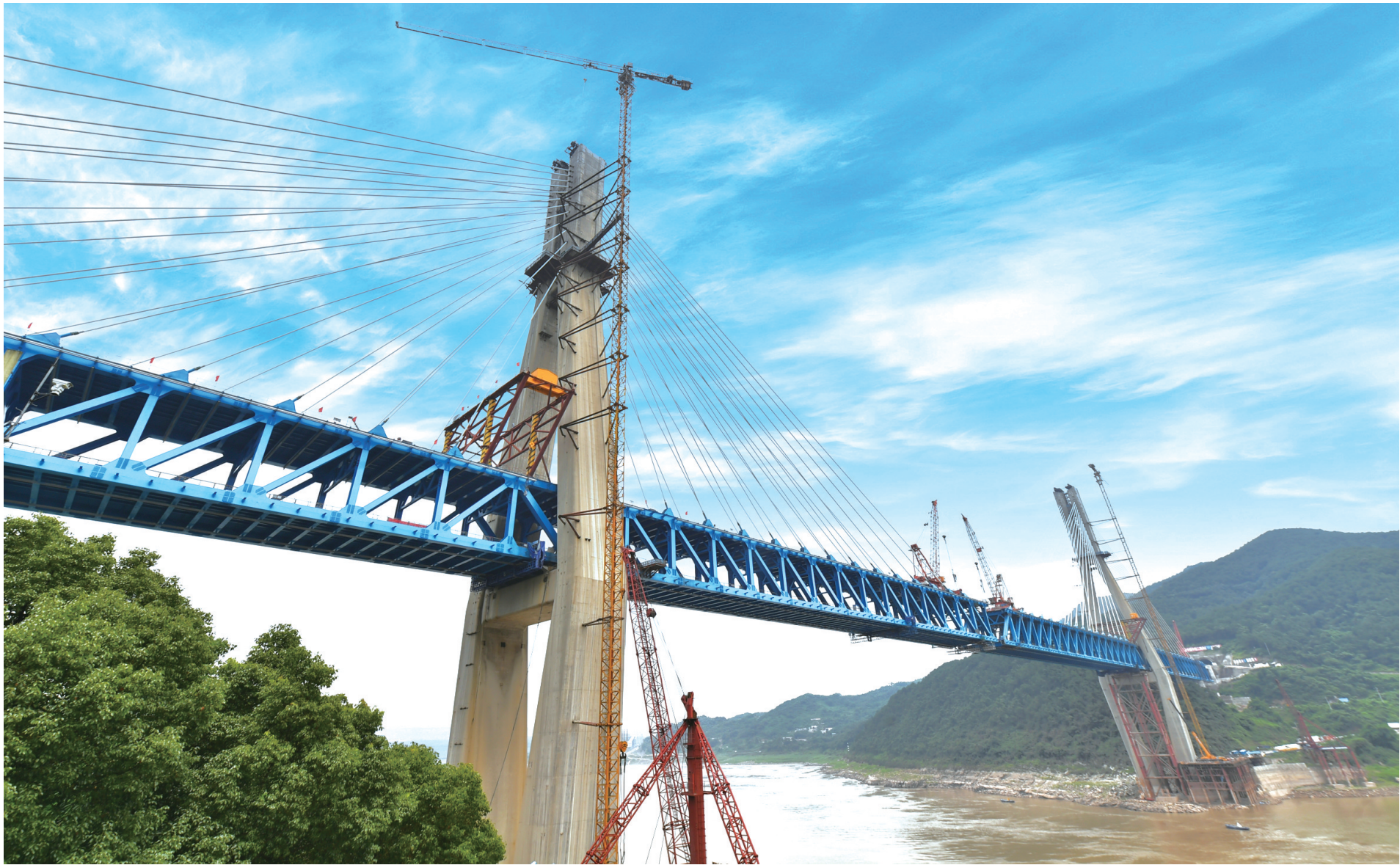
重庆铁路枢纽东环线重要控制性工程明月峡长江大桥即将合龙 摄/郭旭
