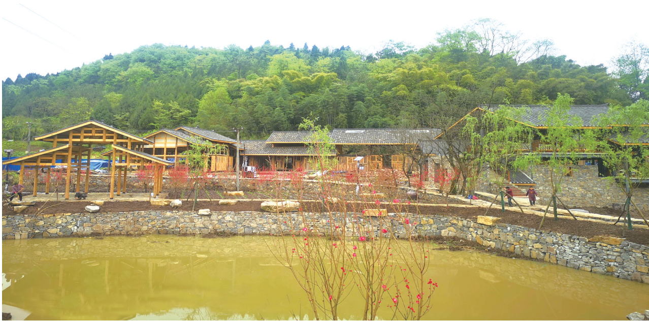
杨家槽项目院落整治成效图
