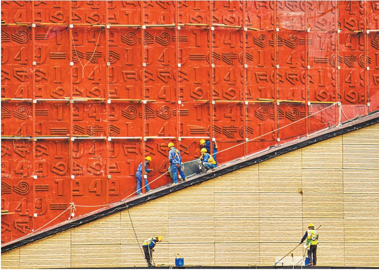
▲6月18日，沙坪坝区磁器口，工人正在对重庆1949大剧院外墙进行装修。
