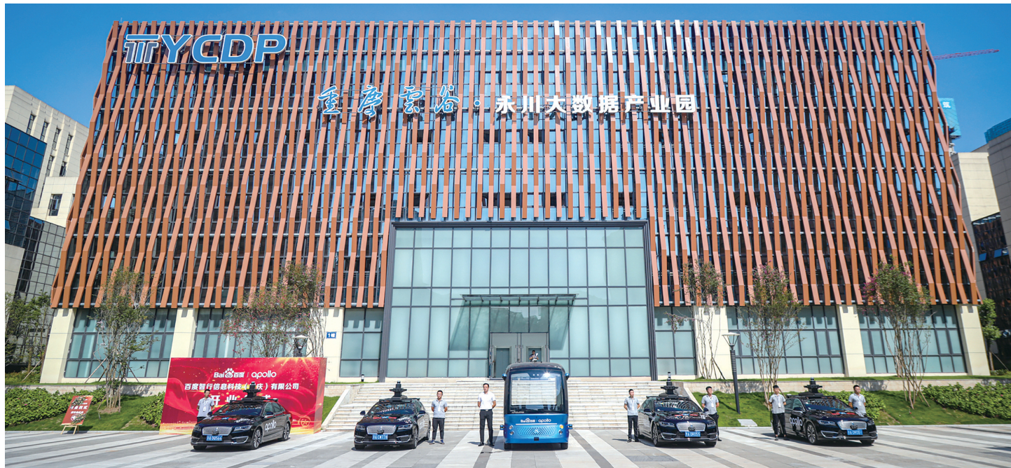
重庆云谷·永川大数据产业园
