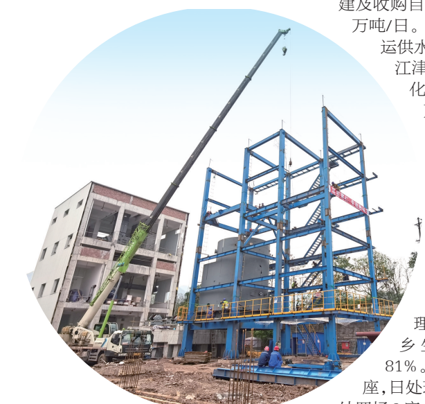
长寿危废建设中场景
