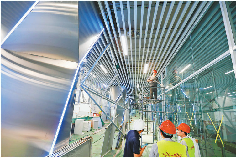
6月2日,位于西部(重庆)科学城的中国自然人群生物资源库正在进行最后的装修工作,拟于本月底正式投用。记者 罗斌 摄/视觉重庆
