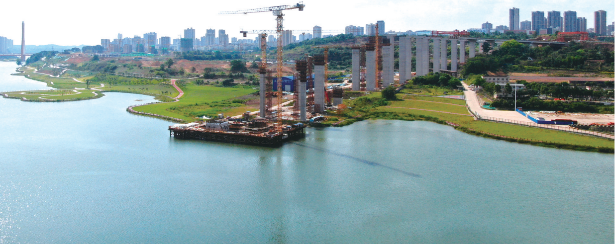
潼南东升大桥施工现场，大桥桥墩已建成，正在进行桥面施工。
