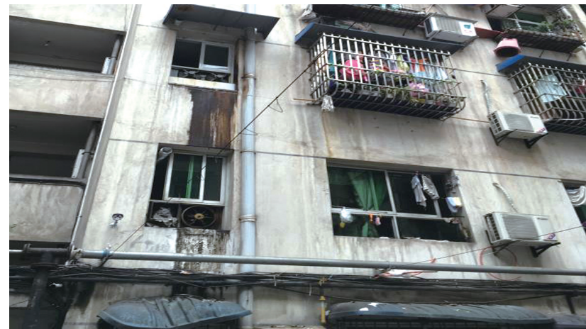
北碚区南京路改造前的旧貌
