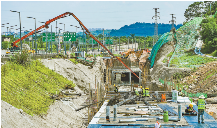
5月16日,西部(重庆)科学城科学大道一期工程现场,工人进行综合管廊施工。
