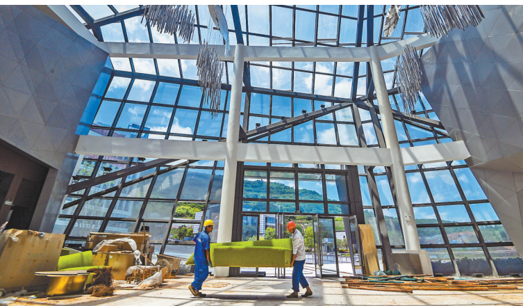
5月16日,西部(重庆)科学城科学谷一期,工人正在进行建筑物内部装修。
