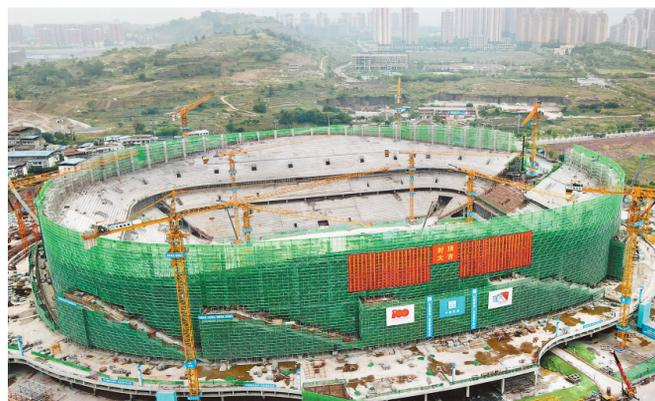
4月28日,重庆龙兴足球场项目的五层主体结构全面完成,正式进入钢结构施工阶段。
