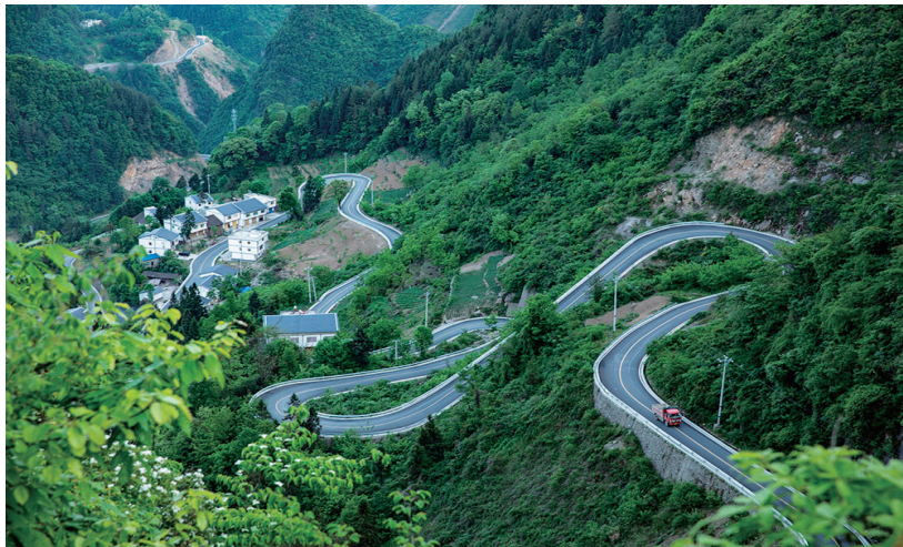
周(溪)双(河)公路 周健 摄/视觉重庆
