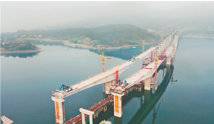
在建的城开高速澎溪河大桥。(高速集团供图)
