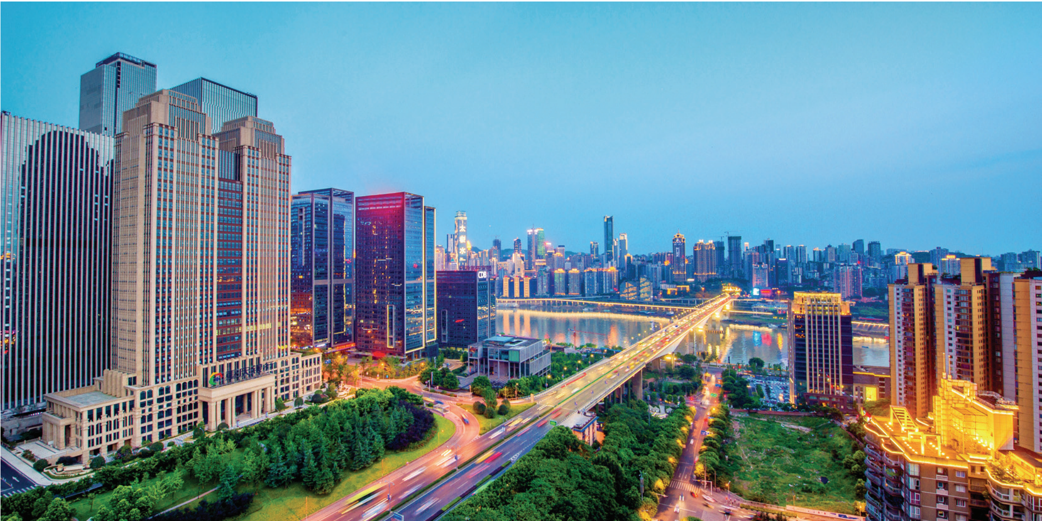
重庆银行总部大楼
