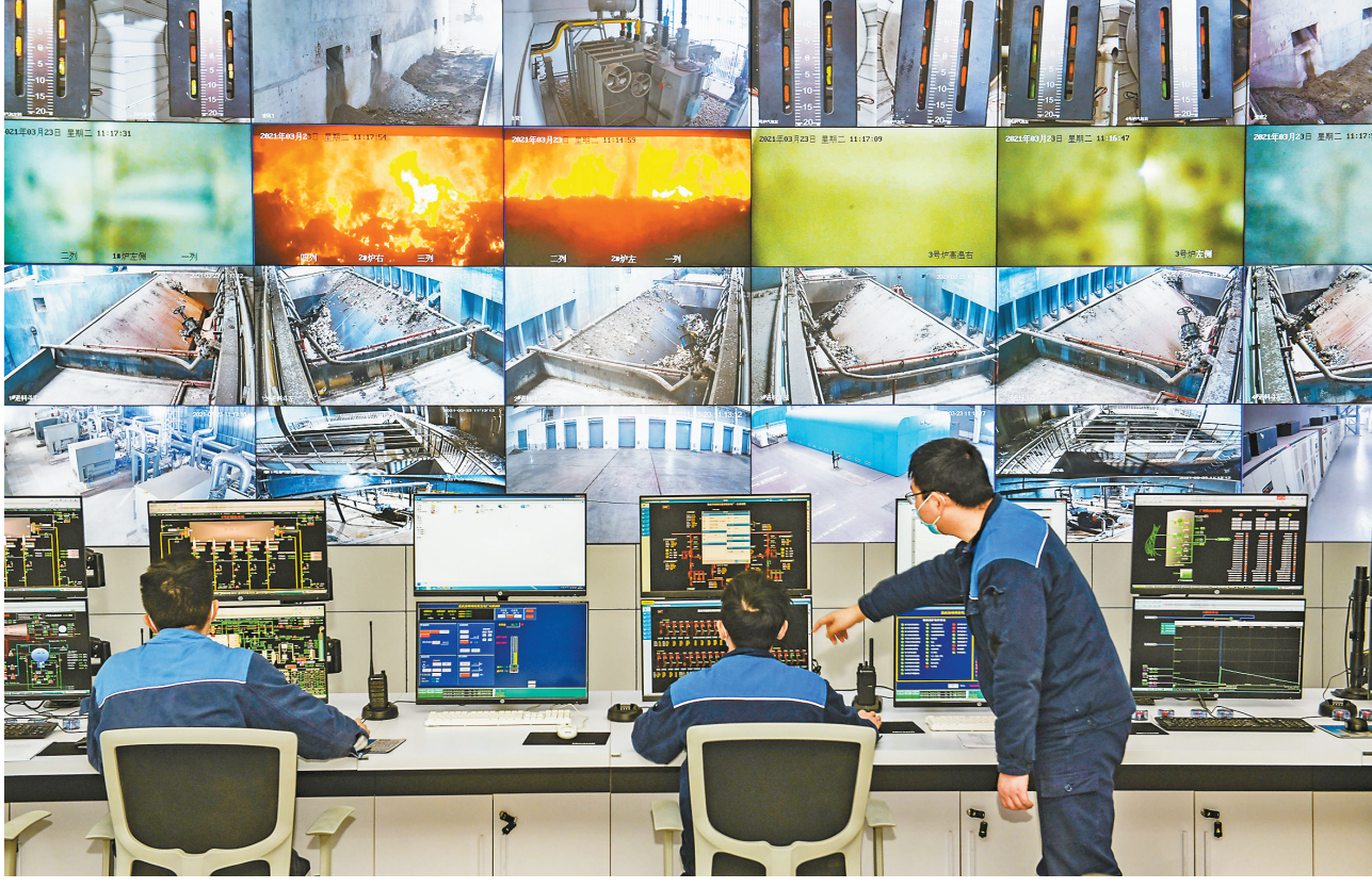
3月23日,中心城区第四垃圾焚烧发电厂,工作人员在中央控制厅监控着各区域运转情况和数据等。
