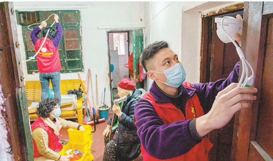
2月2日，沙坪坝区磁器口街道凤凰村，工作人员在独居老人家里安装智能照护设备。本组图片由记者崔力摄/视觉重庆
